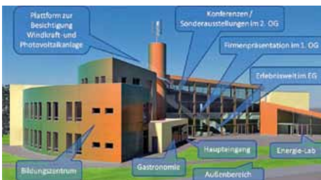
Im Landeszentrum für Erneuerbare Energien in Neustrelitz werden auf einer Fläche von mehr als 2300 m 2 erneuerbare Energien lebendig.
