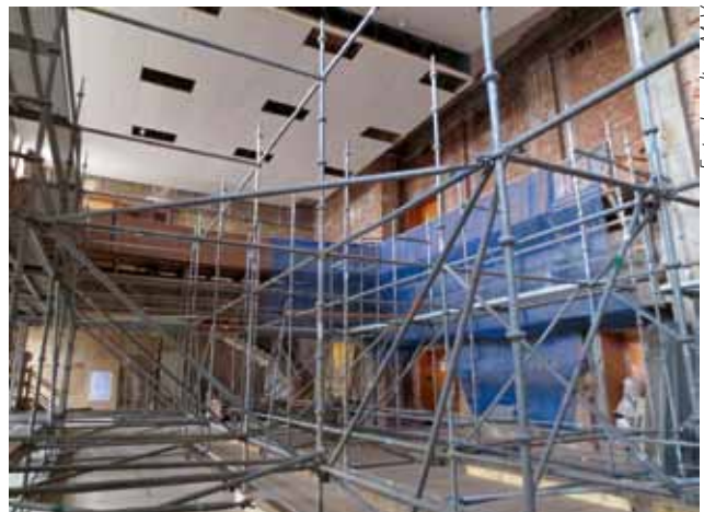
Das 10 Meter hohe Gerüst wird für die Sanierung der Decke des neuen Plenarsaals gebraucht.
