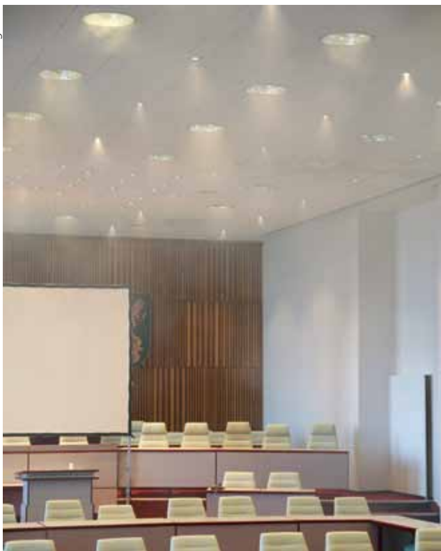
Ein „Rauchtest“ bewies, dass das neue Lüftungssystem im Plenarsaal funktioniert.
