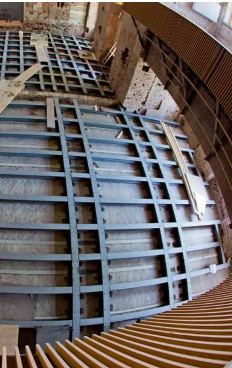
statisch stabilisiert und trägt nun das Gerüst für die Sanierung der Raumdecke.
