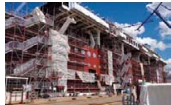
10 Decks sind schon errichtet, 10 folgen noch. Fotos: Landtag M-V
