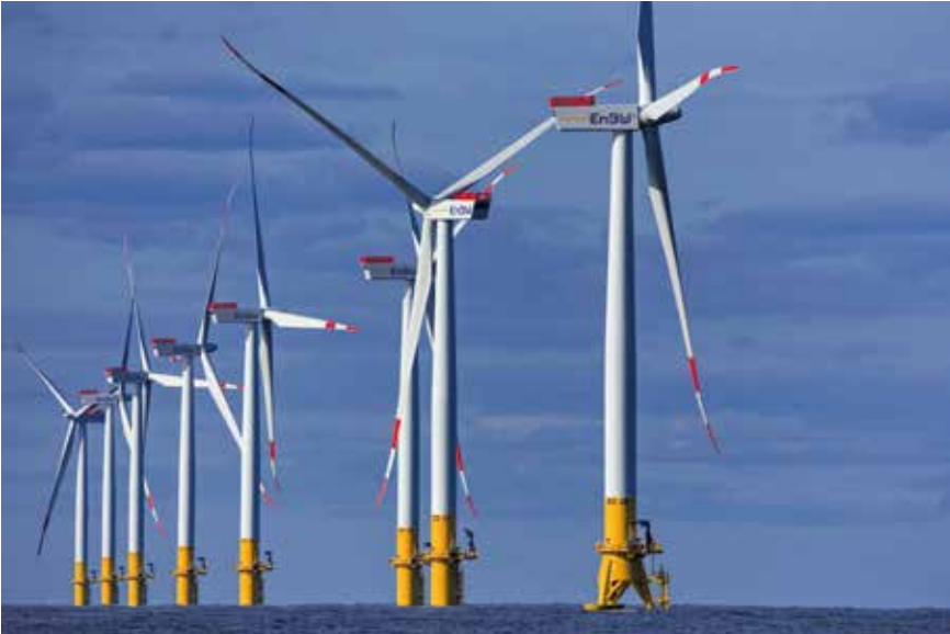
Zu Spitzenzeiten kann es passieren, dass Windkraftanlagen abgeregelt werden müssen, da das Netz durch den produzierten Strom überlastet ist.
