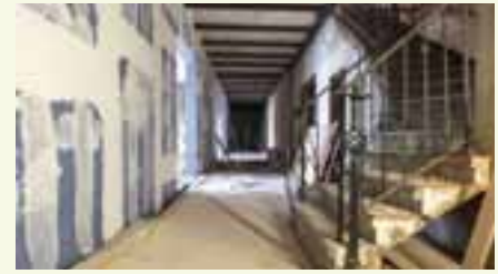
Historie trifft auf Moderne - im 4. Obergeschoss sind Beratungsräume vorgesehen.
