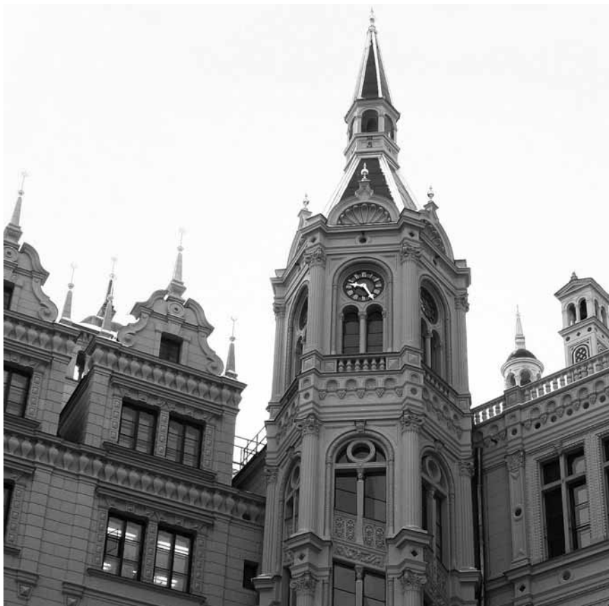
Der sanierte Uhrenturm zwischen dem Haus über der Schlossküche und dem Schlossgartenflügel.
