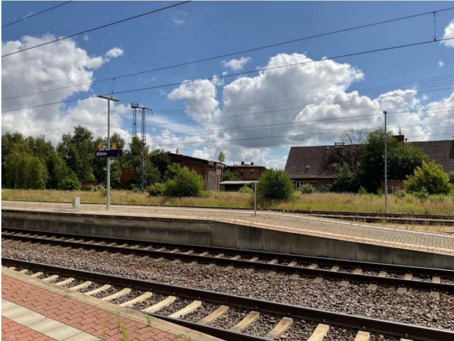
FOTO 1 ED 1 LOKSCHUPPEN IN BÜTZOW (ANSICHT VON WESTEN)
