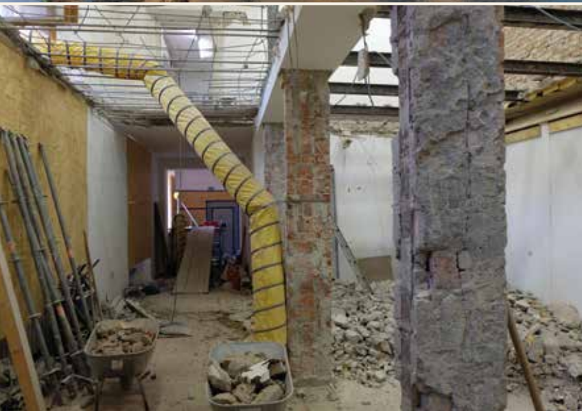
Umbau der alten Lobby – Eine neue Stahlträger-Decke macht Stützpfiler überflüssig. Foto: Cornelius Kettler
