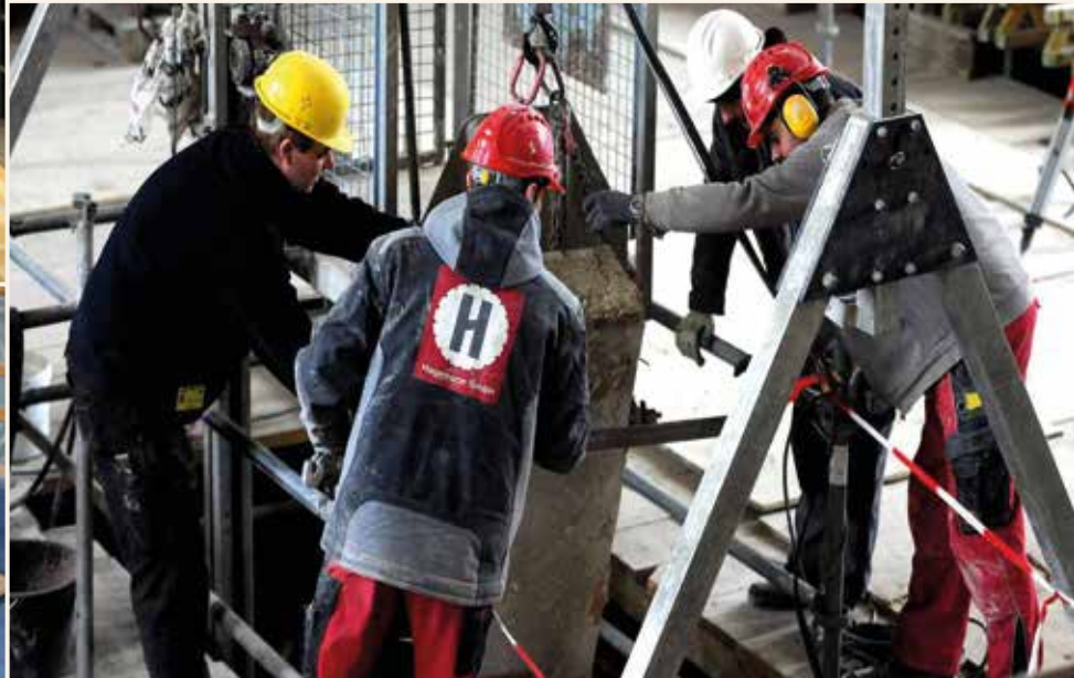
375 Tonnen Beton werden zu 300 kg-Blöcken zersägt und durch die Fenster über einen Bauaufzug abtransportiert. Foto: Cornelius Kettler
