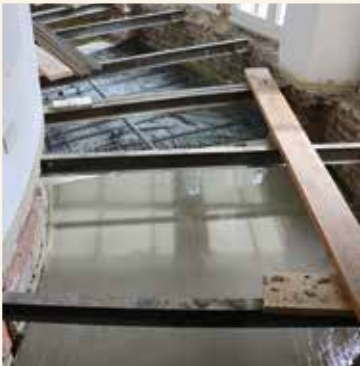
Der Fußboden auf der Besucherebene wird gegossen.
