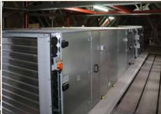
Die tonnenschwere Lüftungsanlage wird im Dachbereich über dem Plenarsaal aufgestellt.
