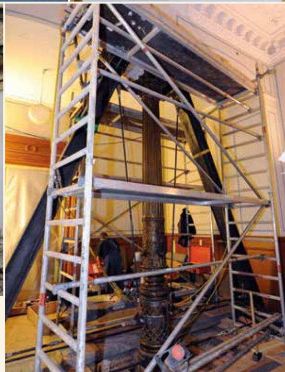
Im Säulenzimmer werden die Guss-Stützen der Gewölbedecke stabilisiert. Foto: Cornelius Kettler
