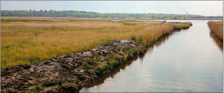
Verwallungen infolge der Ausbaggerungen
