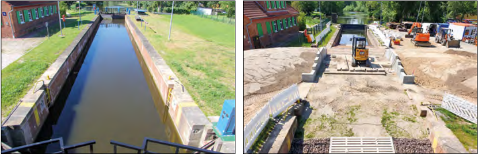
Zustand der Schleuse vor der Trockenlegung (rechts) und danach (links)
