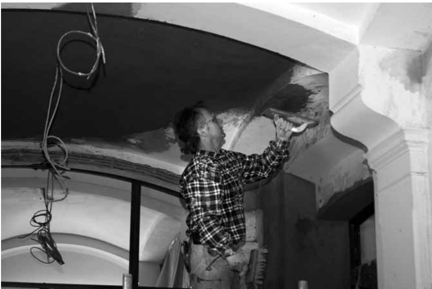
Ein Mitarbeiter der Firma Bauhütte Neumühle beim Verputzen der Decke.
