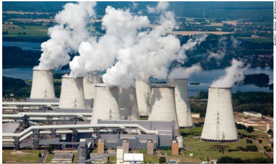
Kühltürme eines Braunkohlekraftwerkes
