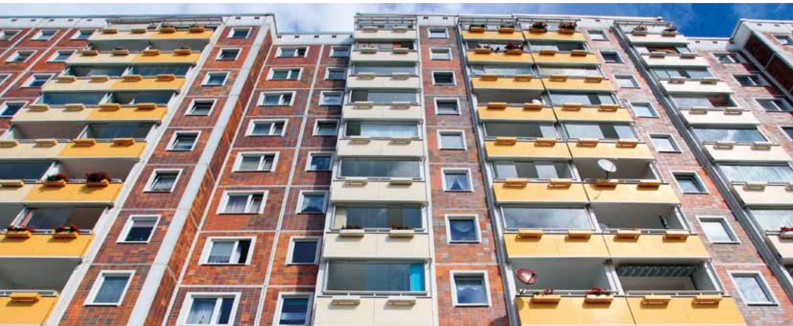
Modernisierter Plattenbau – anderen Blöcken droht wegen Leerstand der Abriss.
