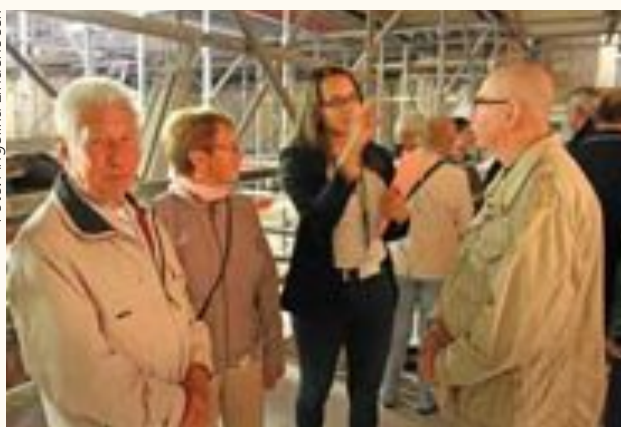
Dominik Peters vom Baureferat erklärt Besuchern am „Tag der offenen Tür“ die Bauarbeiten in der Baustelle des neuen Plenarsaals.
