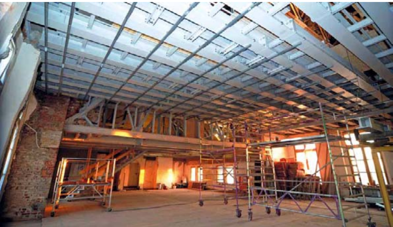
Im 6. Obergeschoss über dem neuen Plenarsaal wurden Fußboden und Decke statisch und brandschutztechnisch erneuert.
