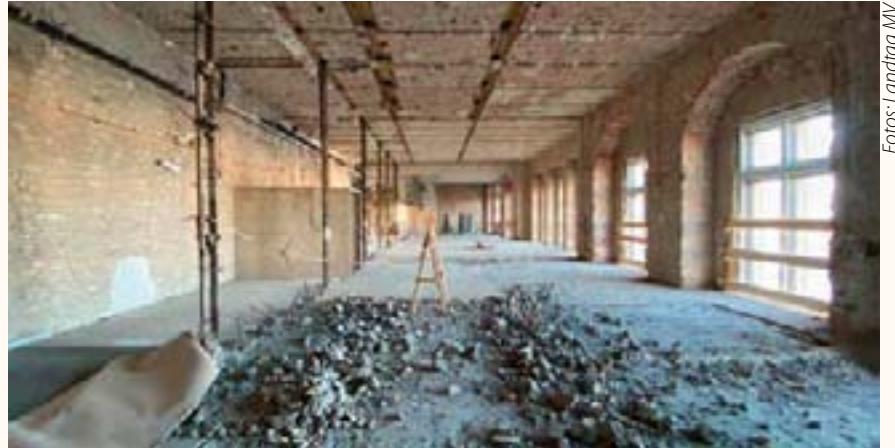
Im 4. OG ist der Bereich der ehemaligen Fraktionsräume der SPD sowie der LINKEN komplett entkernt. Der Fußboden dieses Bereichs wird als Decke des ehemaligen Plenarsaals komplett entfernt und neu errichtet.
