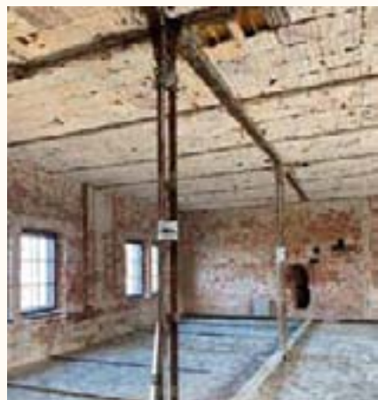
An solchen Abhängekonstruktionen hängen die Decken vom 7. bis zum 3. OG im Burgsee Flügel.
