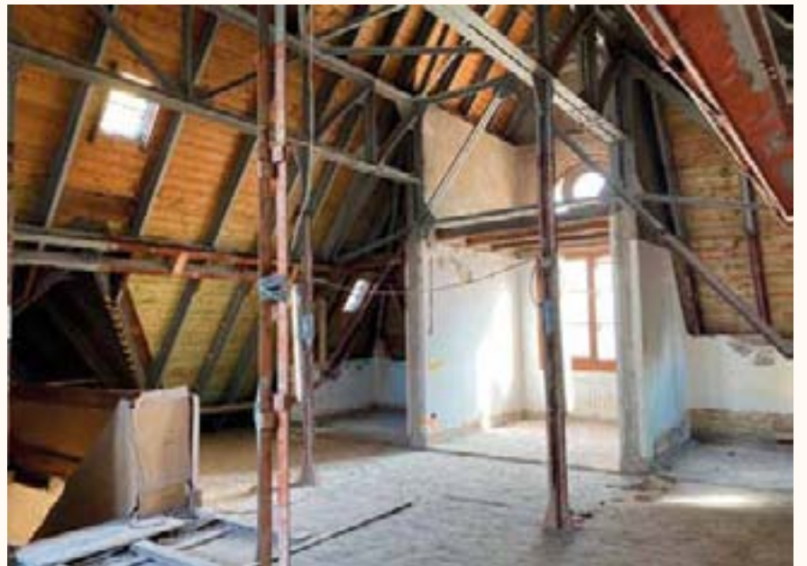
Der Bereich des Mittelrisalits im 7. OG.
