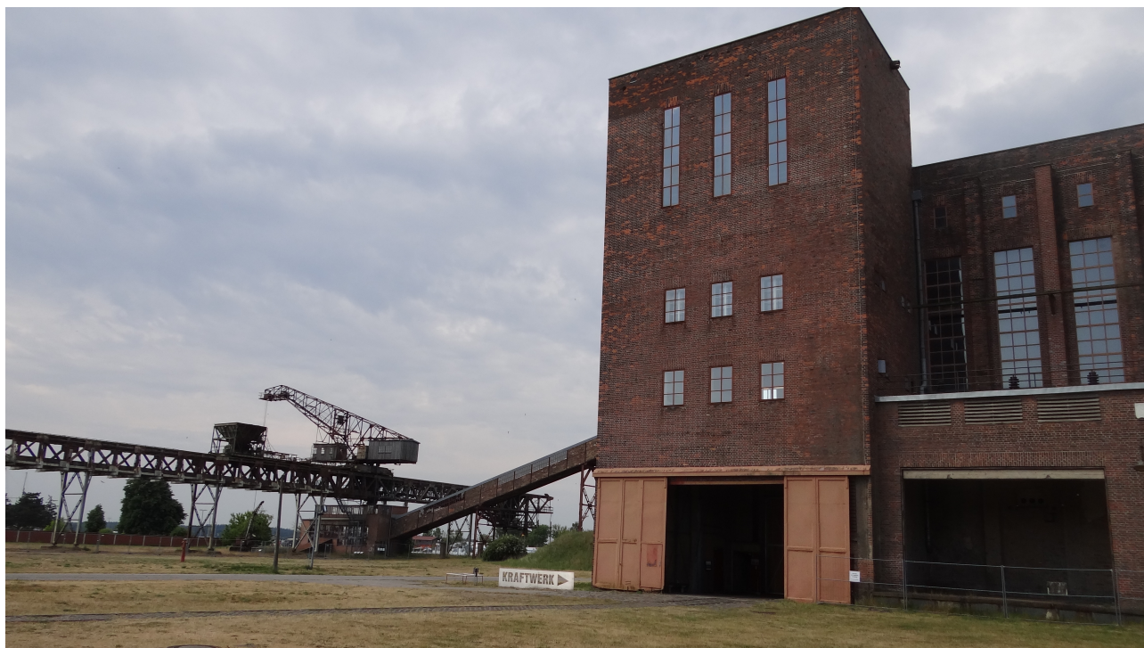
Das ehemalige Kraftwerk auf dem Gelände des HTM-Peenemünde.
