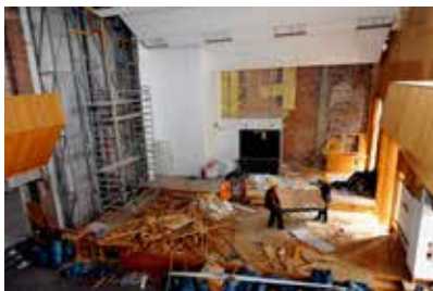
Sommer 2012: Für den Umbau des Festsaals zum neuen Plenarsaal werden zunächst die Stuhlreihen ausgebaut und Einbauten abgebrochen.
