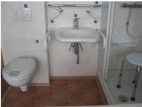
Foto 3 Ein erhöhter Toilettensitz, das unterfahrbare Waschbecken, eine möglichst ebenerdige (nach baulichen Möglichkeiten hier niedrighwellige) Dusche und Haltegriffe gehören zu den dargestellten Anpassungsmöglichkeiten, eigene Aufnahme
