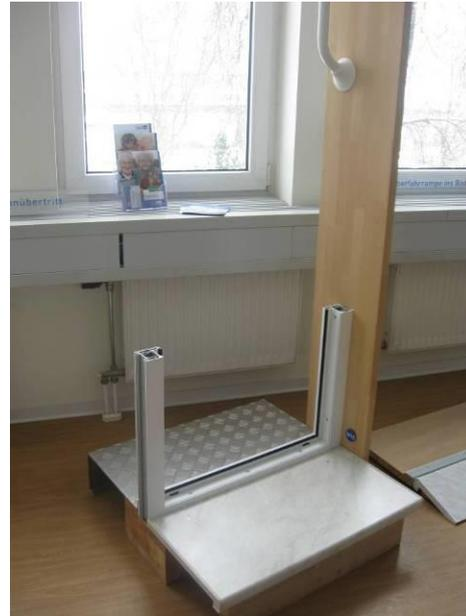
Foto 4 Für die Überwindung der Balkonstufe werden breitere Trittstufen angeboten, bei nur geringerem Höhenniveau kann auch der Anbau einer Schräge gewählt werden, eigene Aufnahme
