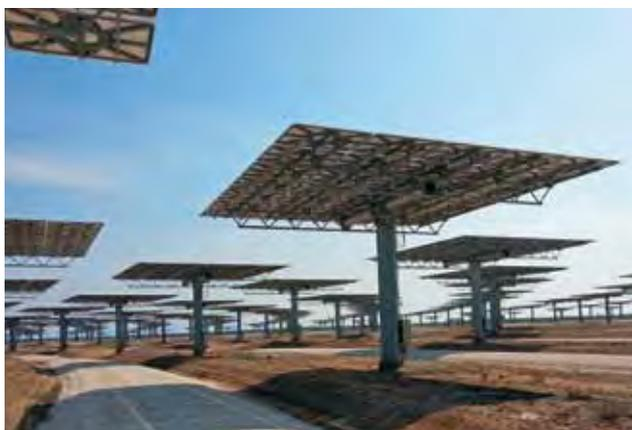
Über eine Möglichkeit der Energiespeicherung informierte sich die Delegation in einem Thermosolar-Kraftwerk. Hier wird Flüssigsalz als Wärmespeicher benutzt. Riesige Konkav-Spiegel werden zur Bündelung von Sonnenstrahlen und damit zur Stromerzeugung eingesetzt.
