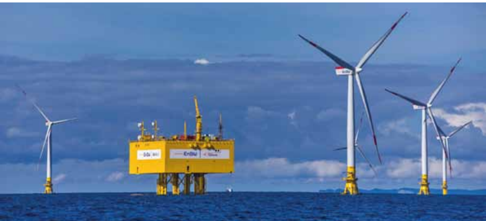
Am 29. September ging der Windpark EnBW Baltic 2 ans Netz. Der Offshore-Windpark 32 km nördlich der Insel Rügen nimmt eine Fläche von 27 km 2 ein und besteht aus 80 Windkraftanlagen und einer Umspannplattform. Das geplante Regelarbeitsvermögen liegt bei 1,2 Milliarden kWh. Foto: Jens Büttner
