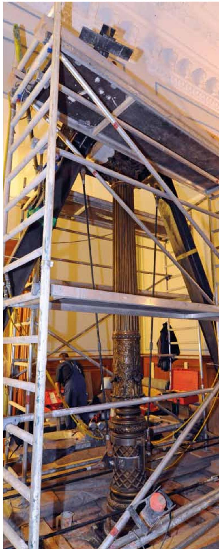
Eine Stahlträgerkonstruktion entlastet die Säule vom Gewicht der Decke, sodass die Fußplatte ausgetauscht werden kann.
