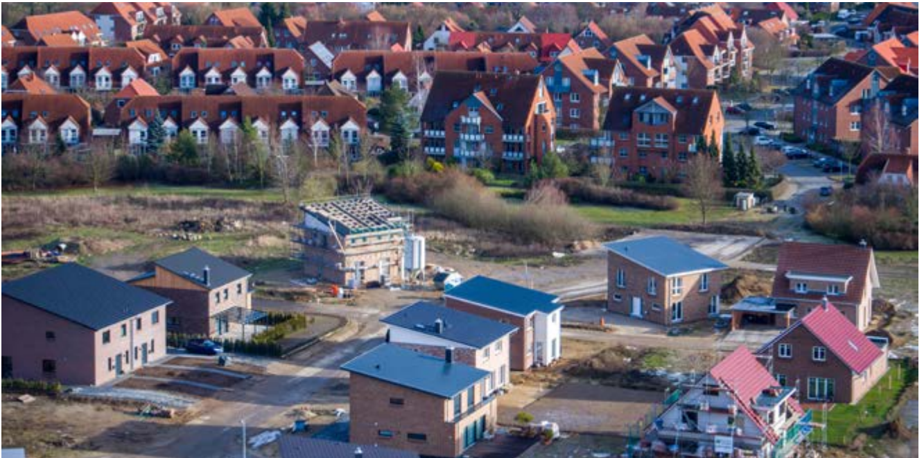
Baugebiet mit Eigenheimen in Schwerin Friedrichsthal
