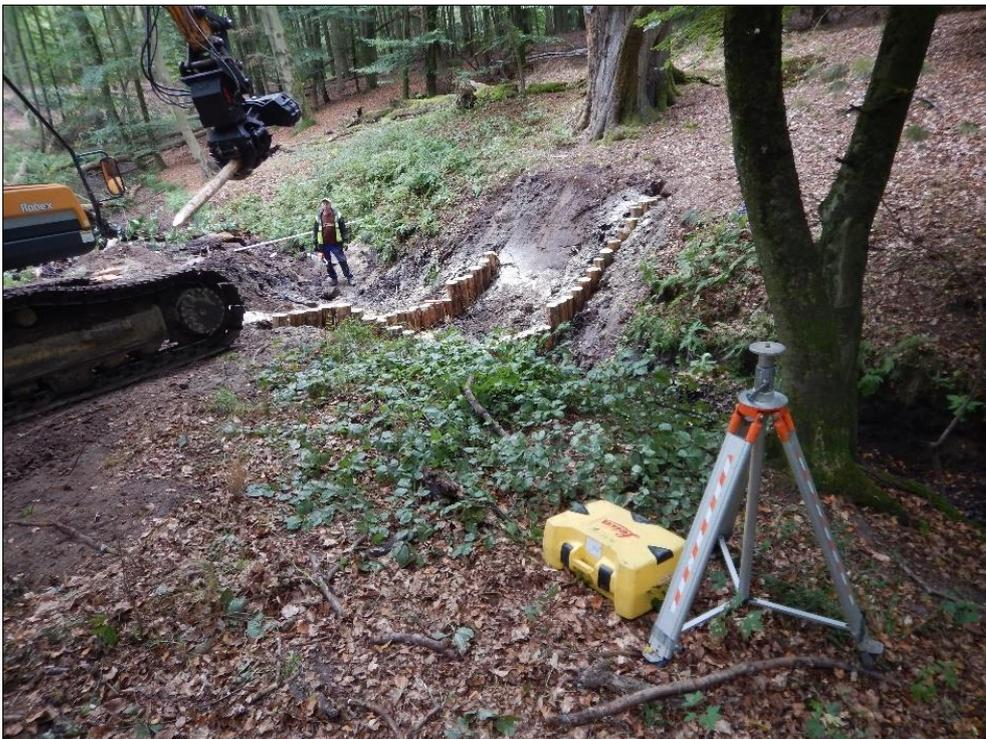
Abbildung 21: Herstellung eines Grabenstaus im Moorschutzprojekt „Klädener Norden“ im Forstamt Sandhof 2019 (Foto: Institut biota GmbH)
