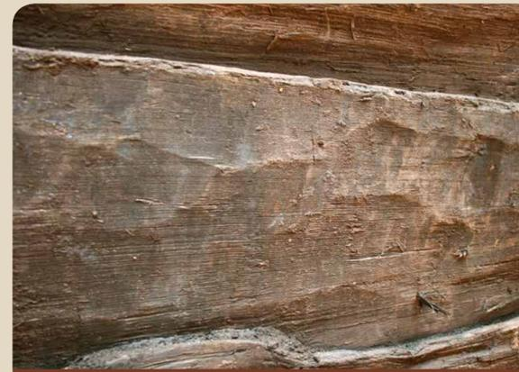
Abb. 4: Werkzeugspuren von einem Dechsel mit ca. 9 cm breiter Schneide.
