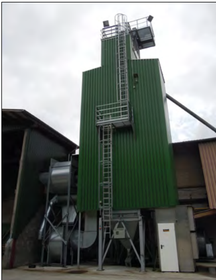
Die Petentin beschwerte sich über Staub- und Lärmbelastungen durch eine Getreidetrocknungsanlage.
